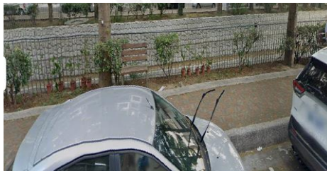
圖 4.2-4 2022 年四月潮洋溪邊坡
