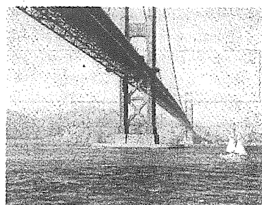
(a). Bridge 的原始影像。
