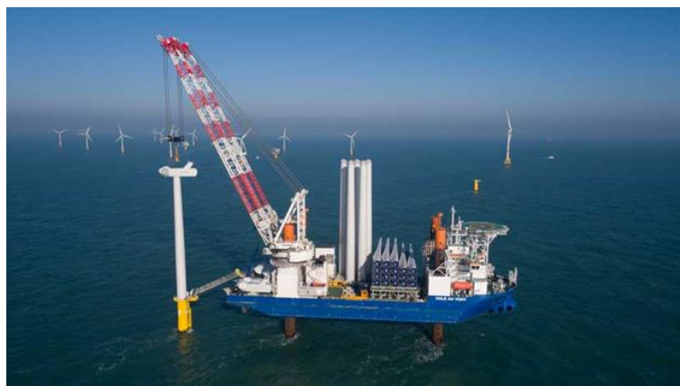
圖 2 自升式平台船安裝風機施工照片
