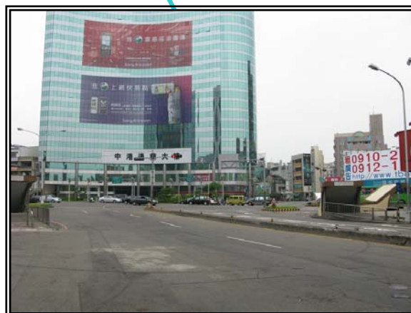
位於中港路與民權路口，中港通商大樓，其建築量體設計為圓弧形，一來除可成為醒目的地標性建築，也配合街廓紋理組構建築，且可減低所面對道路的直衝，設計成有緩衝感。
