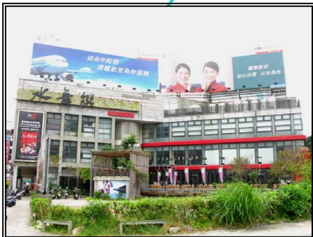
位於公益路與中港路的水舞饌餐廳，由於其正前方面對中港路，且為三角地形，因此將量體設計成有點 V 型，留設前面尖端空地為停車場。
