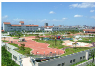
B. 迪化污水處理廠設計為地下化上部規劃為休閒運動公園
