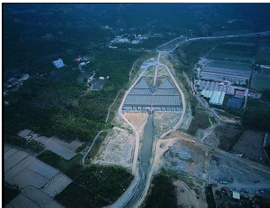
(圖六 北岸沉砂池空拍圖)
