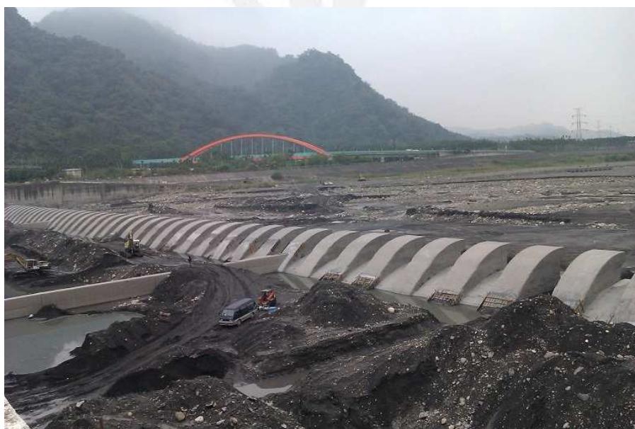
(圖十二 集集攔河堰之護坦尾檻(整流消能工))
