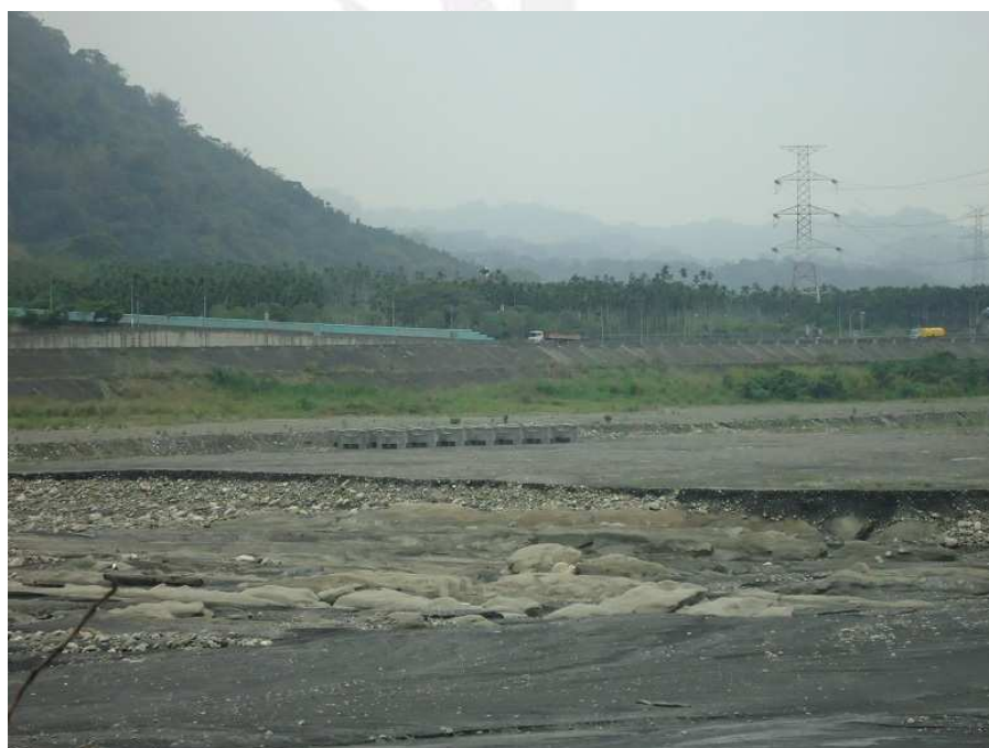
(圖十八 集集攔河堰下游河道)
