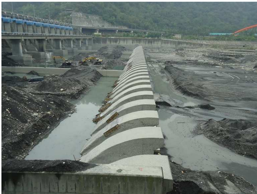
(圖十一 集集攔河堰之護坦尾檻(整流消能工))
