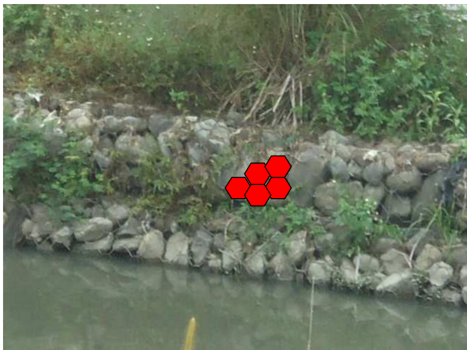
(圖二十五 石籠固床工)
