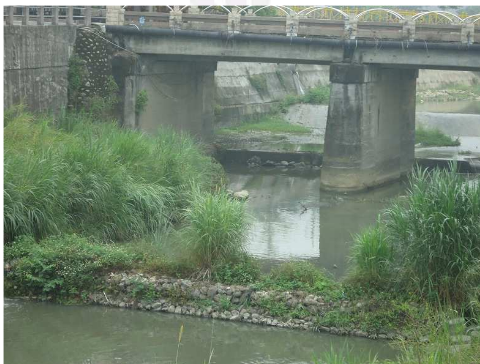
(圖二十四 石籠固床工)
