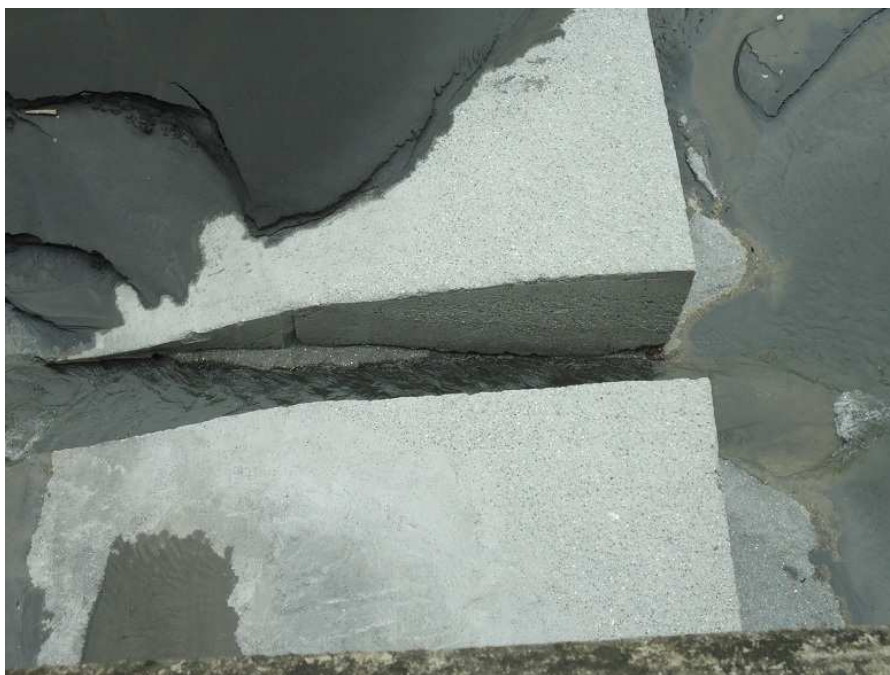
(圖十七 集集攔河堰之排砂閘門下游之護坦尾檻)
