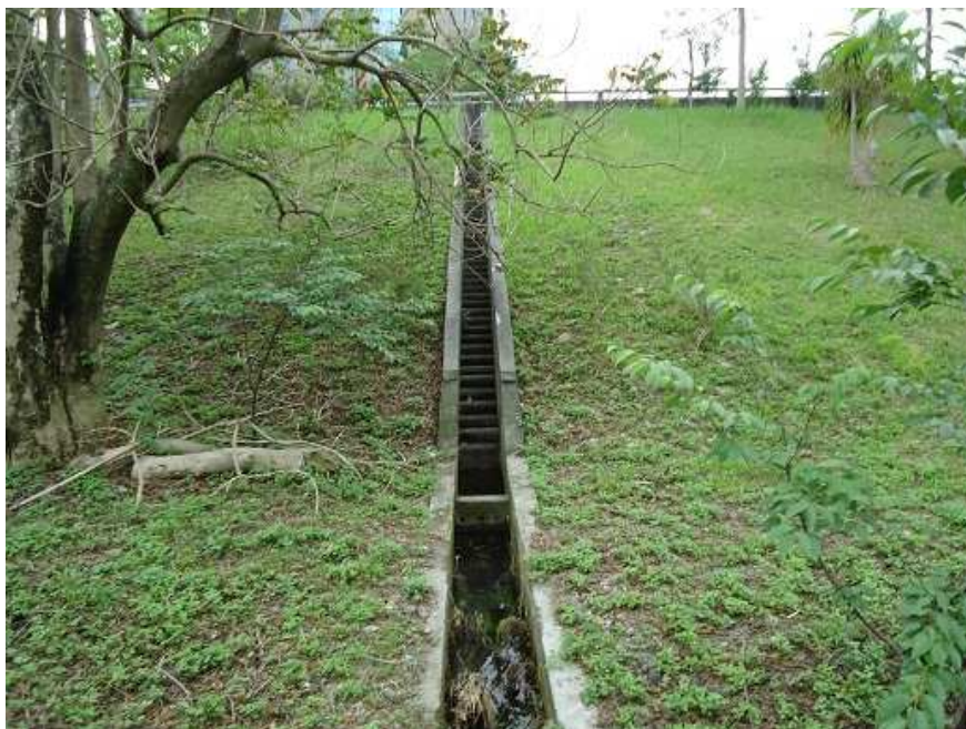
(圖三十一 邊坡排水溝)
