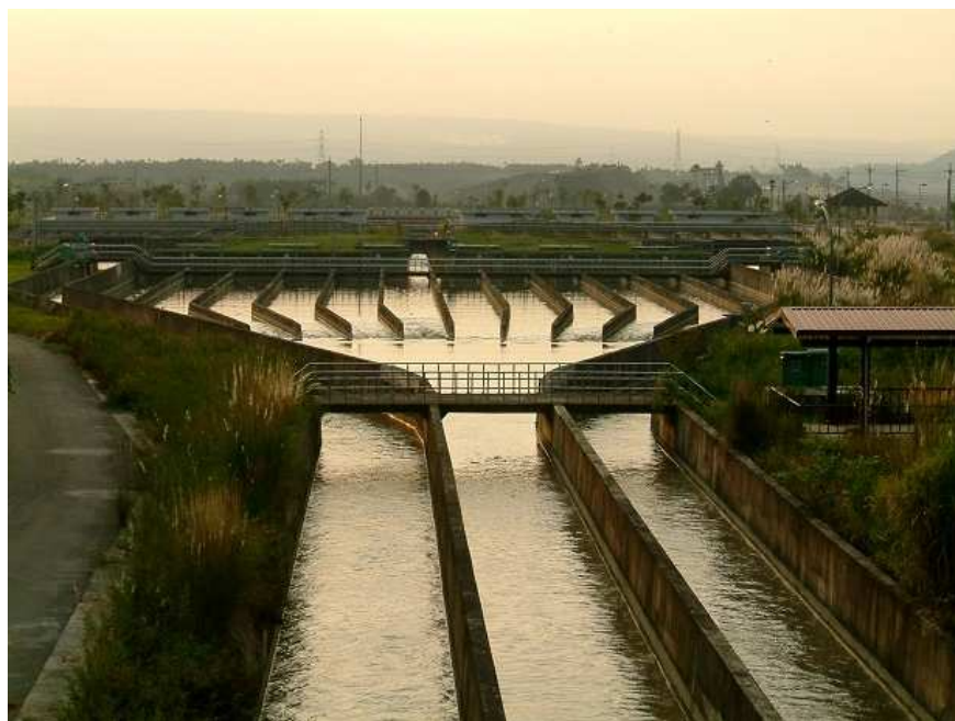
(圖七 南岸沉砂池)
