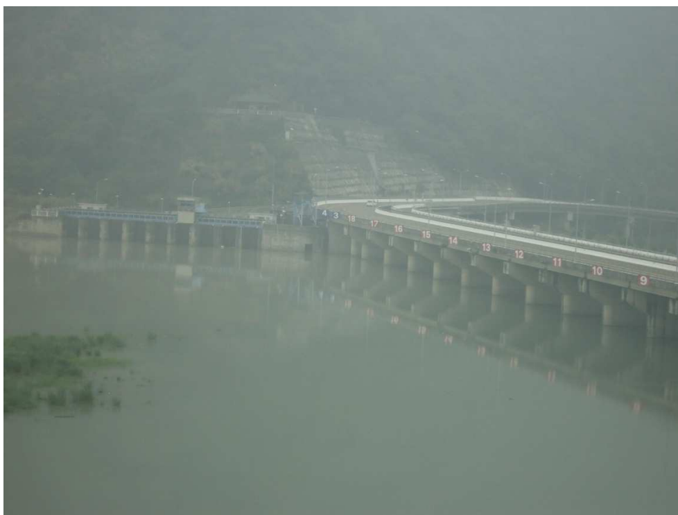
(圖五 南岸進水口&魚道入口)
