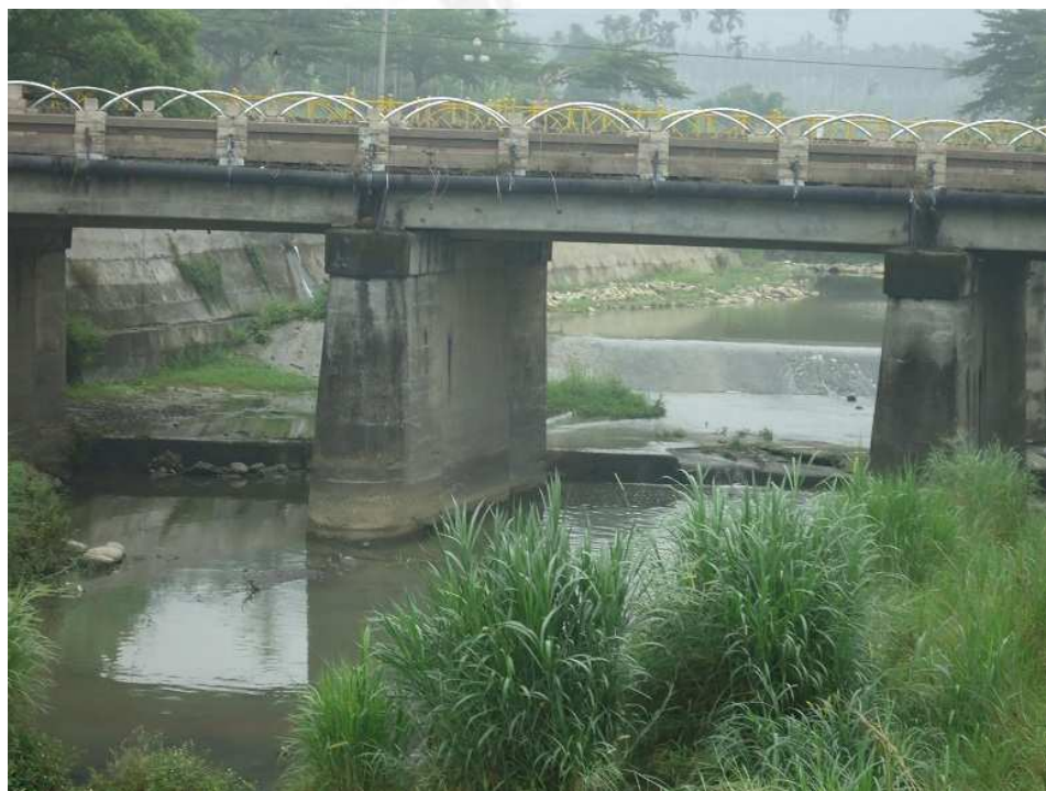
(圖二十七 橋墩上方突起物)
