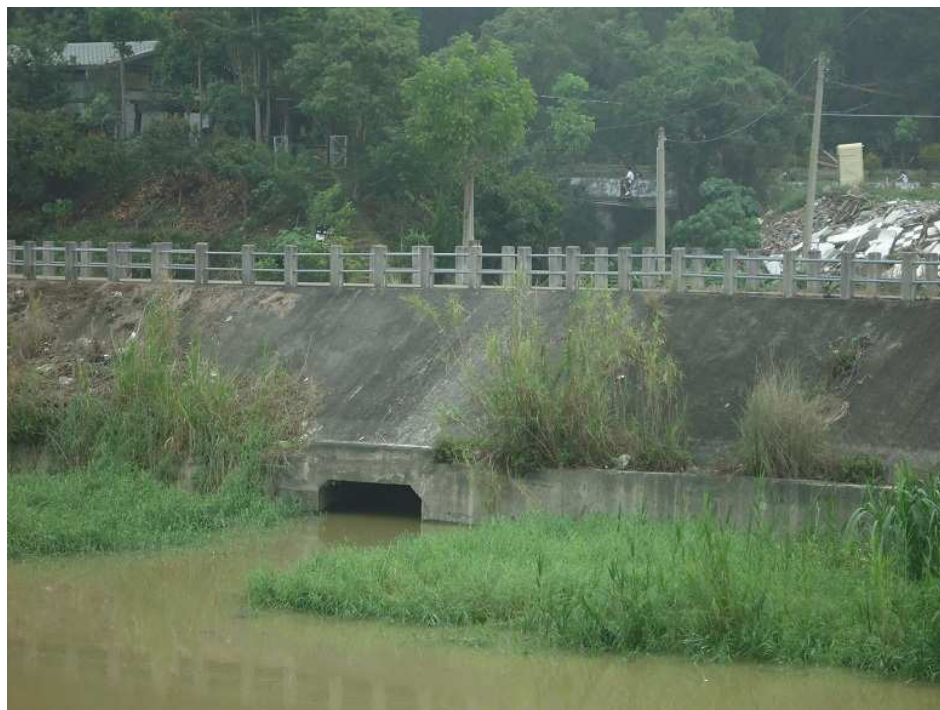
(圖二十二 北清水溝溪堤防的一箱涵)
