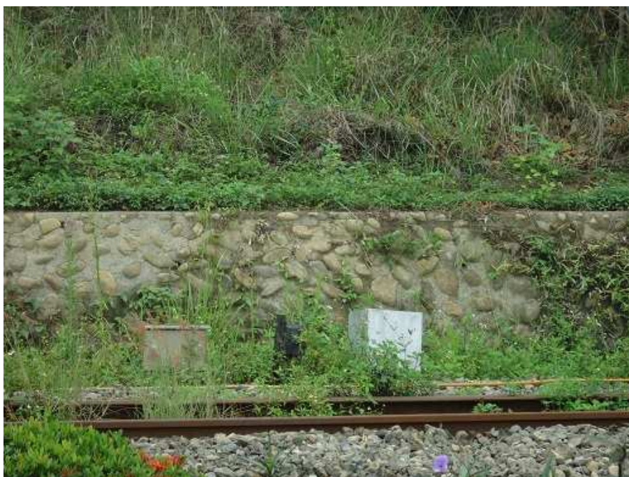
(圖二十九 混凝土砌塊石邊坡)
