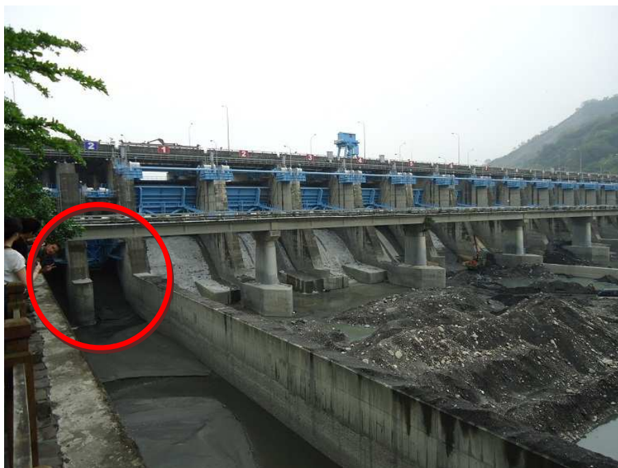
(圖十六 集集攔河堰之排砂閘門)
