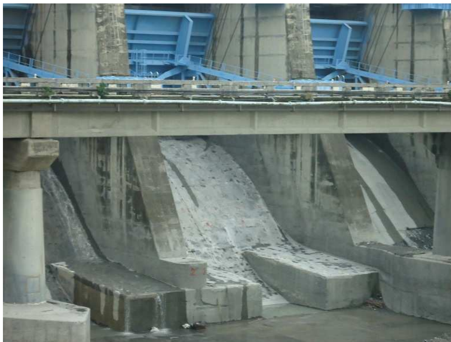
(圖十三 集集攔河堰之溢洪道)
